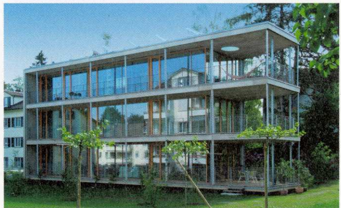
▲ Sieger des Passivhaus-Architekturpreises 2010: ein Dreifamilienhaus
